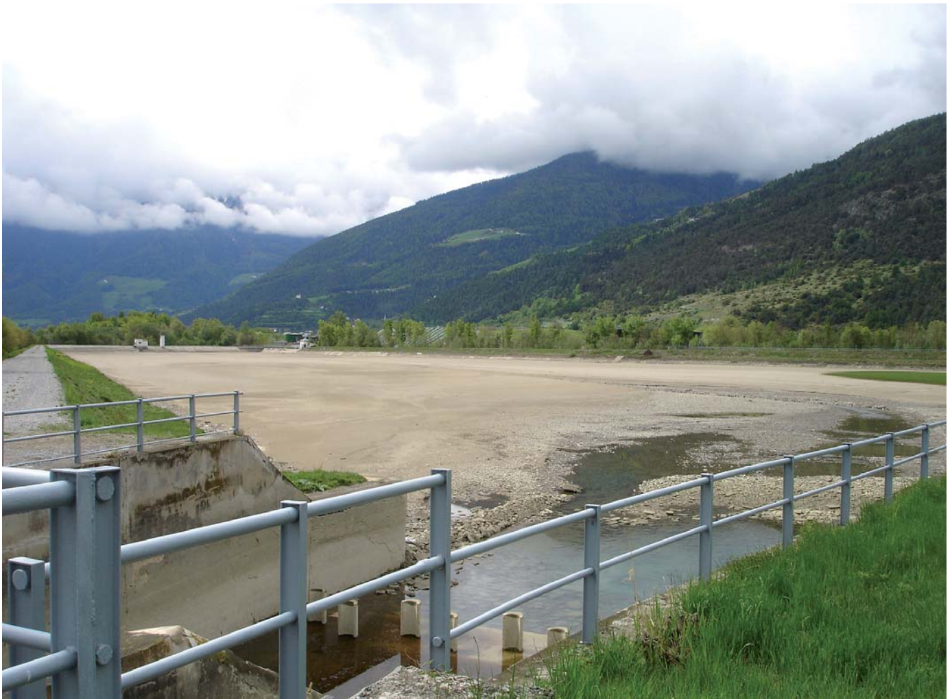
Bild 3. Bestehendes Ausgleichsbecken im Vinschgau, Südtirol – das sich prinzipiell auch für eine Schwall/Sunk-Dämpfung eignen würde. Das Becken hat ein Volumen von 400000 m 3 .
