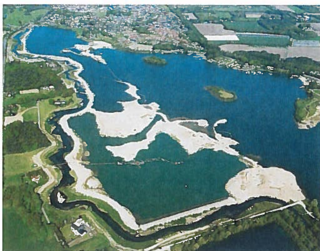
Abb. 8: Schrägluftbild der fertig gestellten Lippeseumflut am Südufer des Lippesees im 2. Jahr nach der Inbetriebnahme
