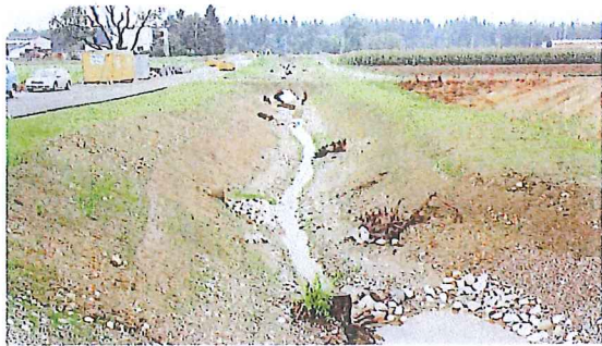
Bauarbeiten Wasserbau: Seemattgraben , kurz nach Bauvollendung
