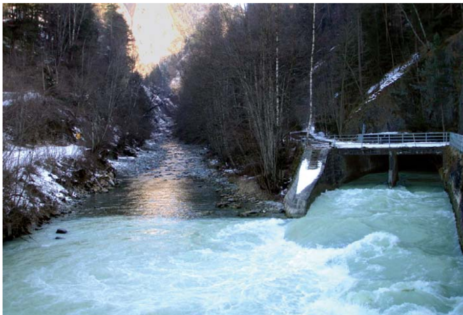
Bild 1a. Rückgabe des aus dem Grimselgebiet stammenden Wassers (rechts) in das Gadmerwasser (links) unmittelbar vor der Mündung in die Aare.
