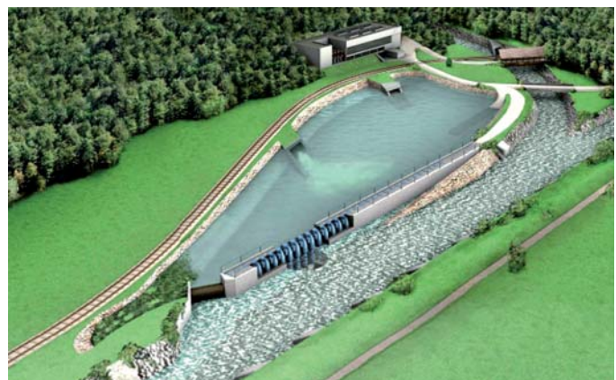
Bild 3. Schematische Darstellung des geplanten Beruhigungsbeckens zwischen Aare, Gadmerwasser und der Meiringen-Innertkirchen-Bahn.
