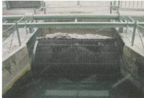
Tambour rotatif avec espacement des barres de 25 mm (DWA 2005)
