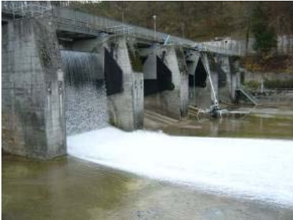
Pas de bassin d'affouillement
