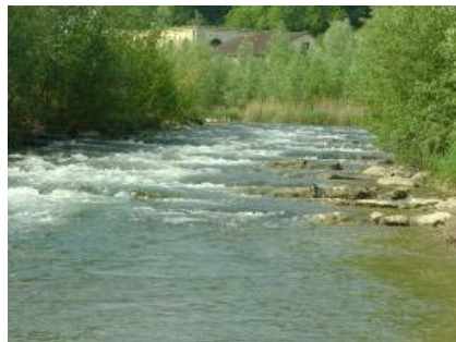
Rampe en enrochements, Aar
