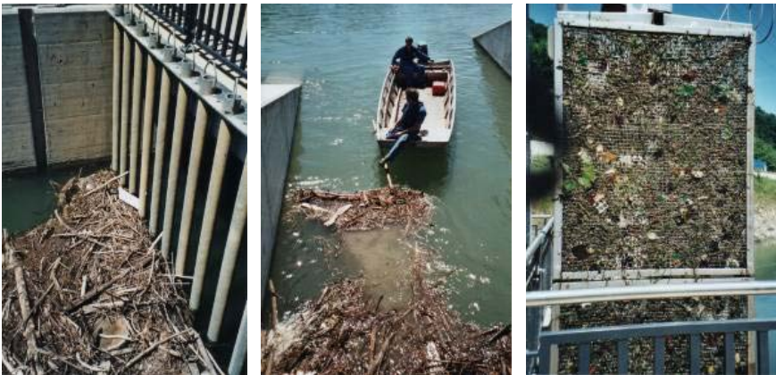
Corps flottants à l'entrée d'un cours d'eau de contournement ou d'une nasse de contrôle (Aquarius).
