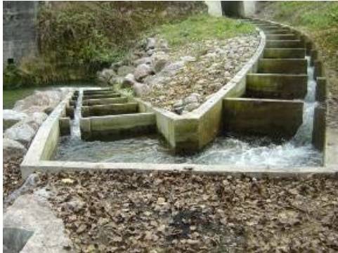
Bassin de repos dans l'angle d'une passe à fentes verticales, Tôss (Aquarius)
