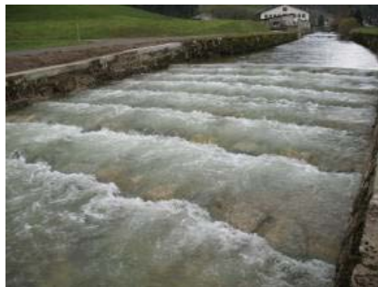
Rampe en enrochements, les Buttes (Aquarius)
