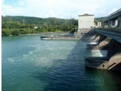
Bassin d'affouillement continuellement en eau (Aquarius)
