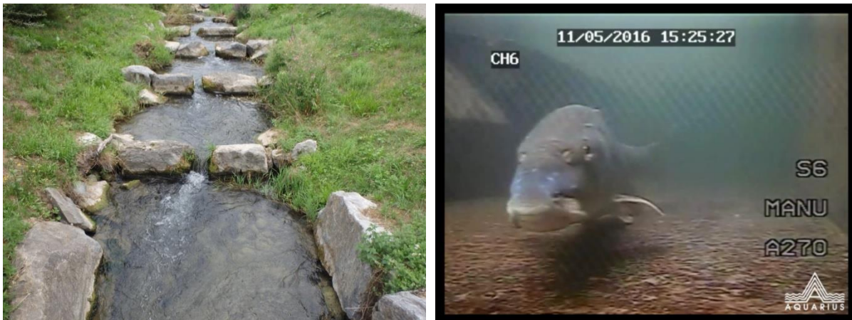
Abb. 2: Insbesondere in naturnahen Anlagen muss überprüft werden, ob die geforderten Werte auch während des Betriebs eingehalten werden (links). Bei Abstiegsanlagen kann anhand einfacher Untersuchungen festgestellt werden, ob z.B. Sohleitrinnen ihre Funktion noch erfüllen (rechts) (Aquarius)
