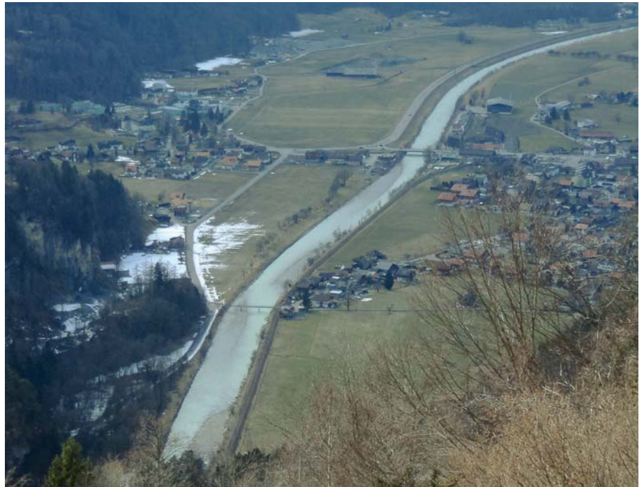
Bild 2. Kiesbank- und Kanalstrecke in Meiringen (Fließrichtung von links unten nach rechts oben).
