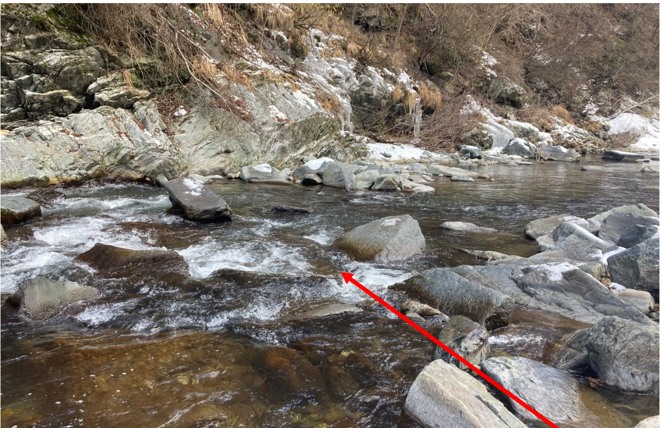
Figura 4-8: la rampa dopo il ripristino; si può notare come il dislivello sia scomparso (freccia rossa indica il punto di cedimento ripristinato)
