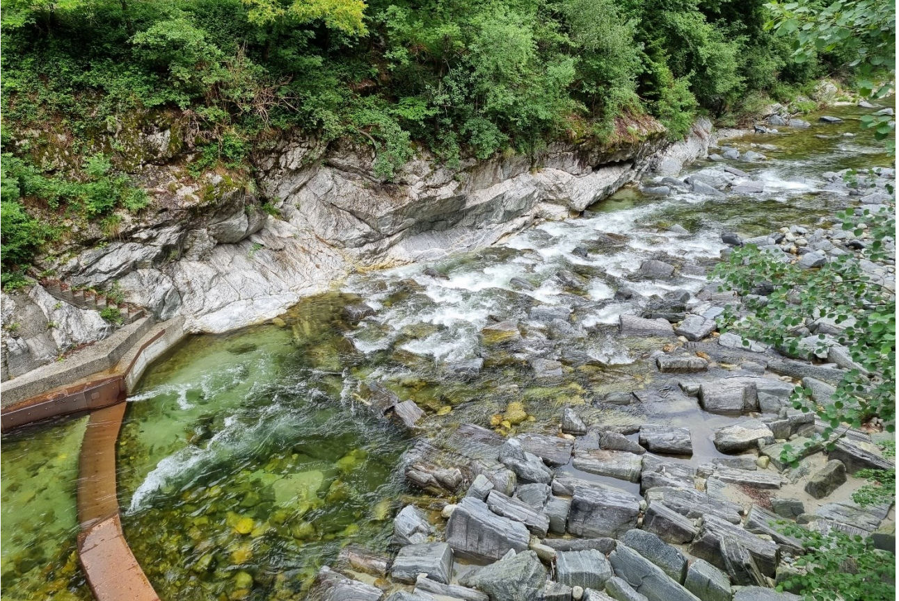
Figura 5-13: Maggio 2022 – visione complessiva della rampa
