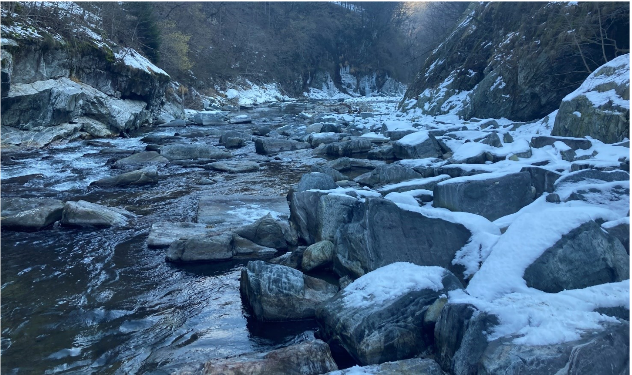
Figura 5-8: febbraio 2022 – tratto centrale della rampa (tratto non interessato dal cedimento)
