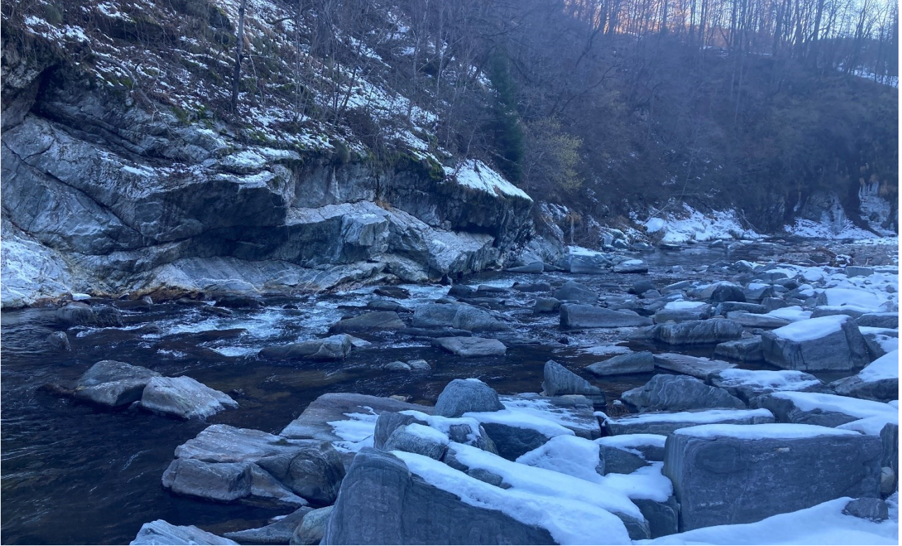
Figura 5-7: febbraio 2022 – tratto centrale della rampa (tratto non interessato dal cedimento)
