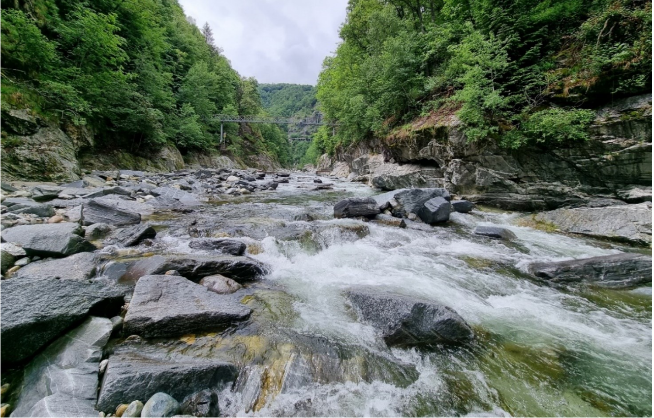
Figura 5-11: Maggio 2022 – tratto terminale della rampa (tratto interessato dal cedimento)
