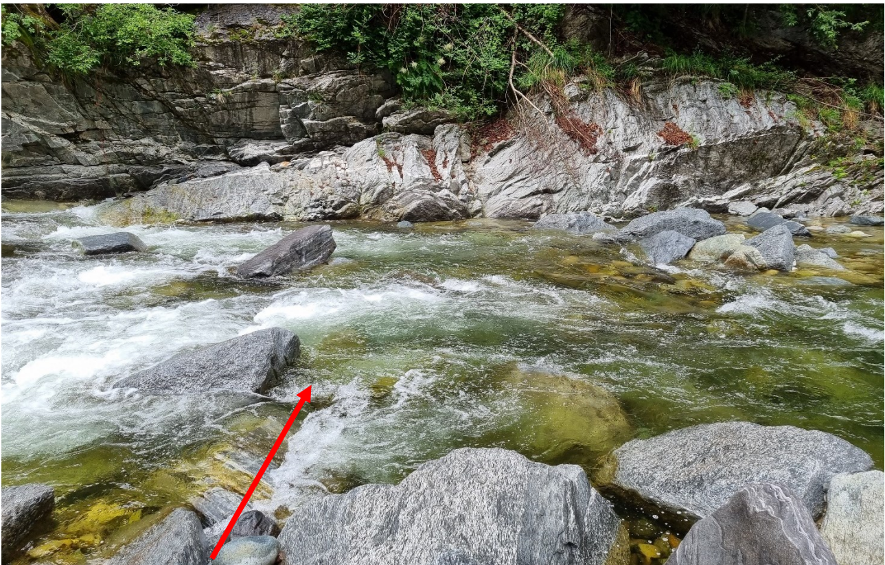
Figura 4-6: la rampa dopo il ripristino; si può notare come il dislivello sia scomparso (freccia rossa indica il punto di cedimento ripristinato)
