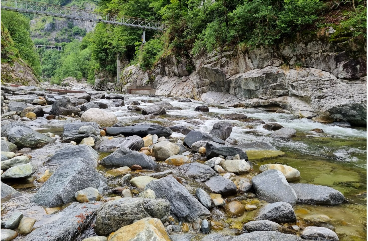
Figura 5-9: Maggio 2022 – tratto centrale della rampa (tratto non interessato dal cedimento)
