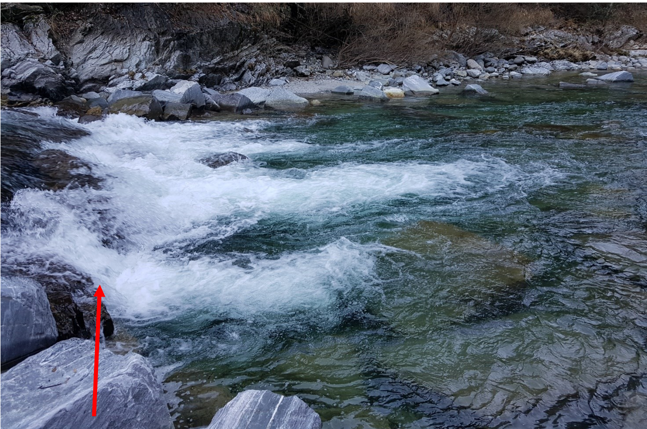
Figura 4-4: la rampa dopo il cedimento (freccia rossa indica il punto di cedimento)
