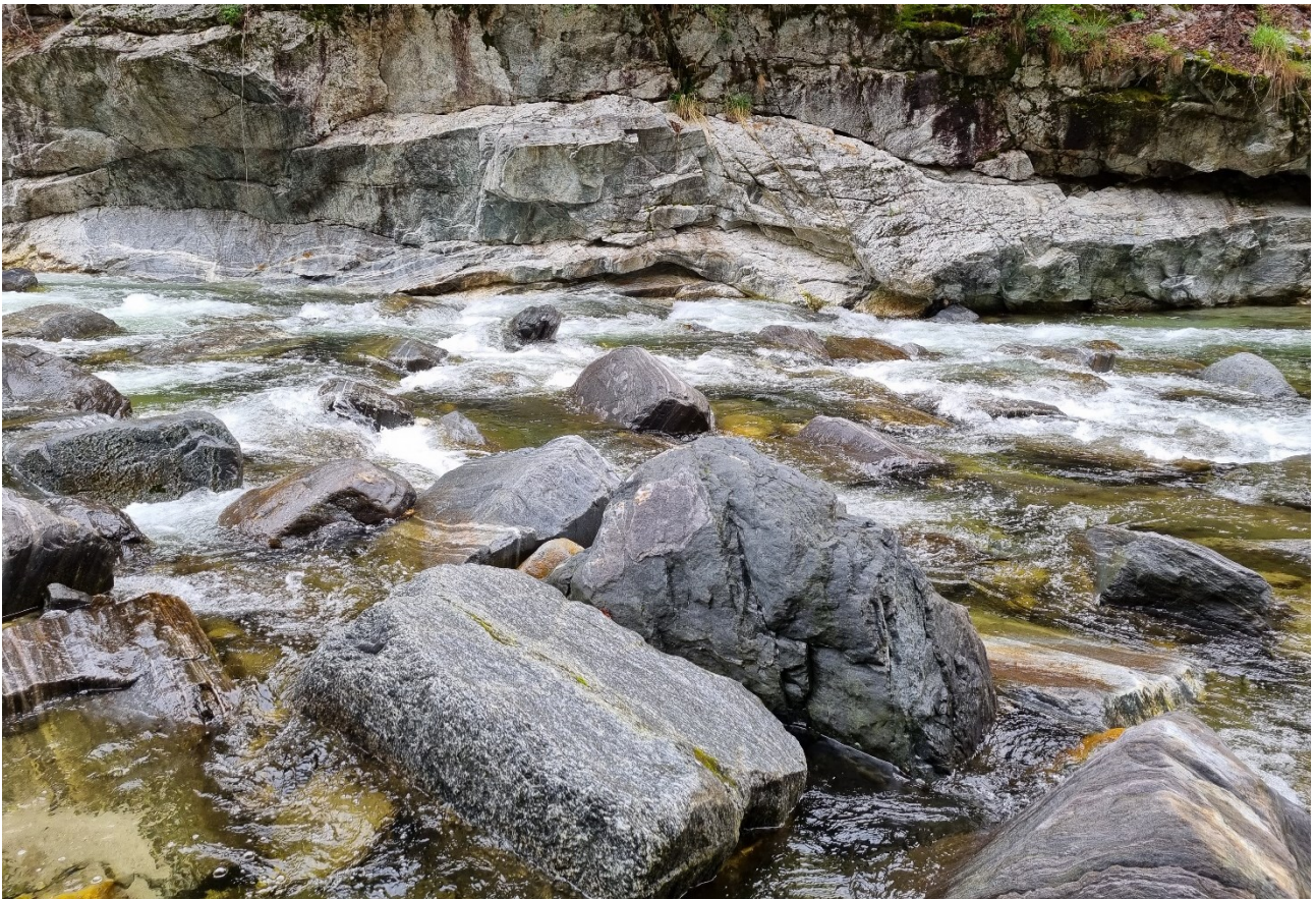
Figura 5-10: Maggio 2022 – tratto centrale della rampa (tratto non interessato dal cedimento)
