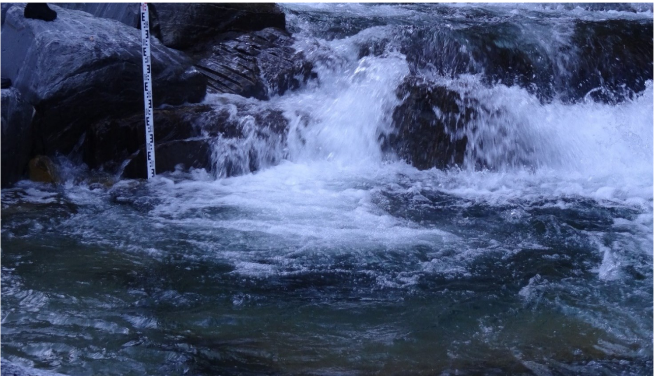
Figura 5-2: dicembre 2018 – punto di cedimento nella tratta terminale (ca. 1 m di dislivello)
