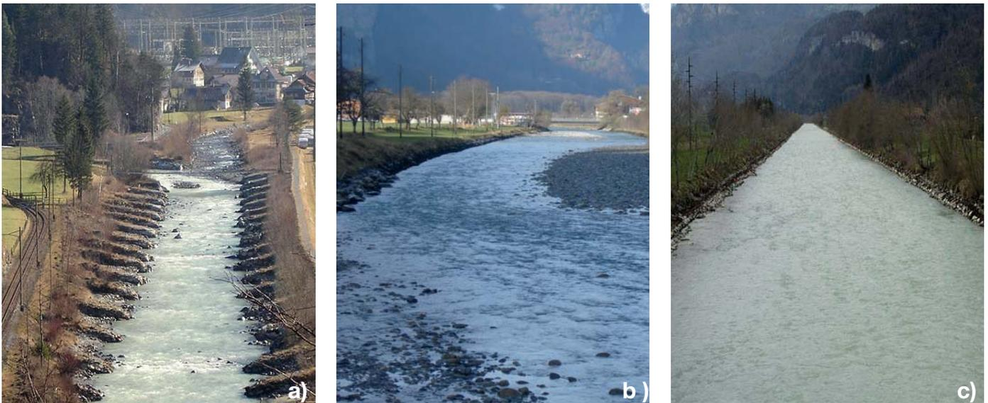
**Bild 1.** Die Hasliaare: Bühnen- (a), Kiesbank- (b) und Kanalstrecke (c). Im Rahmen der Hochwasserschutzprojekte «Innertkirchen» und «Meiringen bis Brienersee» sowie im Zuge des Investitionsprogramms KWO plus (Schweizer et al., 2012b) sind verschiedene morphologische Aufwertungen in der Hasliaare geplant. Dabei handelt es sich u.a. um grössere Flussaufweitungen, Absenkungen der Vorländer und Förderungen zur Ufer- und Gewässerstruktur.
