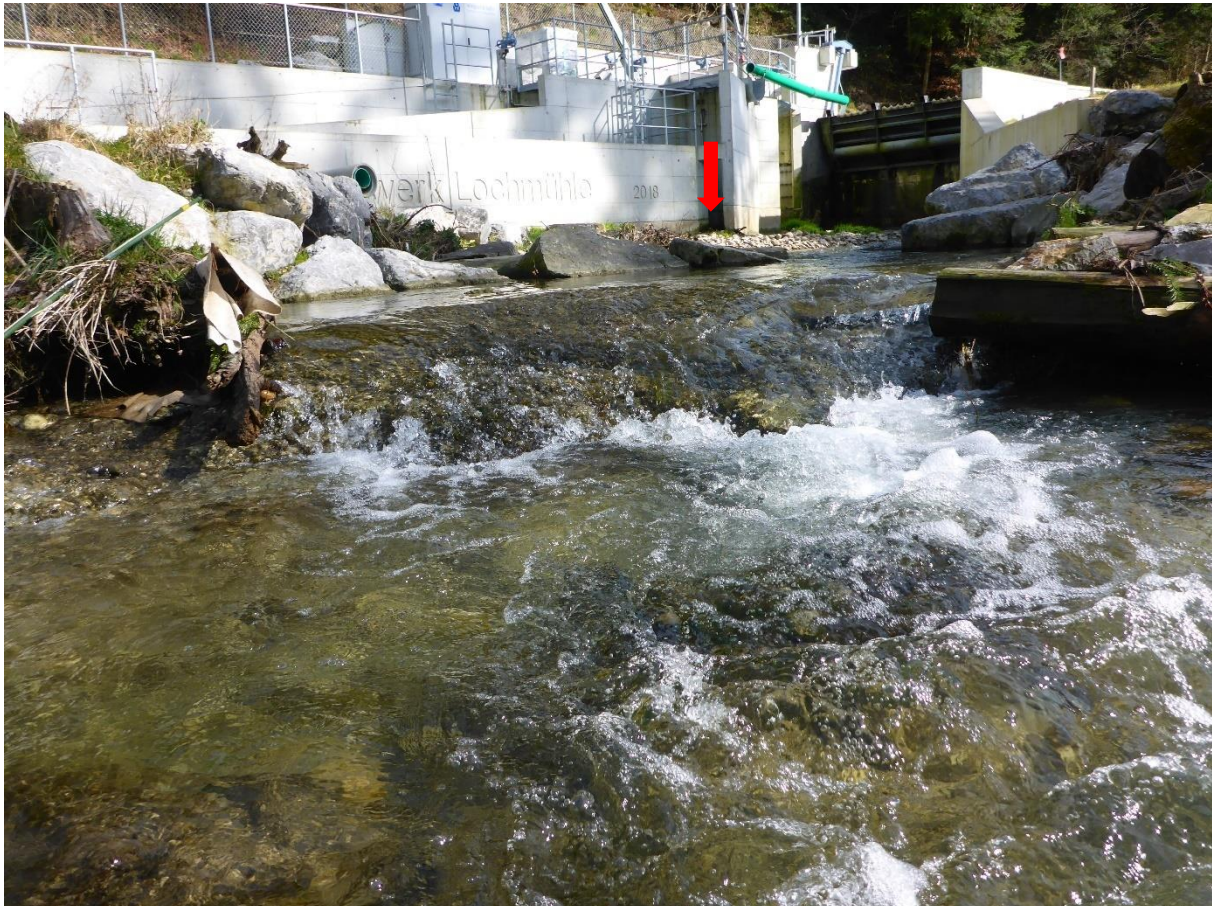
Abb. 12 Nagelfluh-Rampe flussabwärts des Wehres, Blickrichtung flussaufwärts. Im Hintergrund: Einstieg in die FWH (roter Pfeil).
