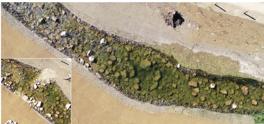
Figure 12 Vue par drone de la zone de repos. En médaillon, la zone de repos amont a été complétée par un épi afin de réduire les vitesses sur la partie supérieure de la rivière de contournement. Source : Aquarius, 2019.
