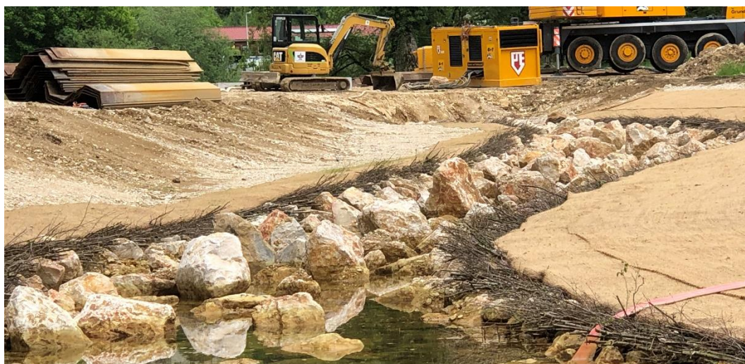
Figure 6 Détail des macrorugosités avant la mise en eau du dispositif. Source, Aquarius, 2019.
