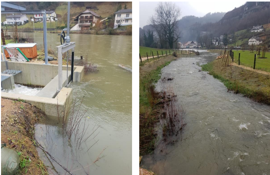
Figure 15 Prise d'eau et rivière de contournement le 24.12.2019 avec un débit du Doubs d'environ 150 \text{ m}^3/\text{s} . Source : Valenti Iseli.
