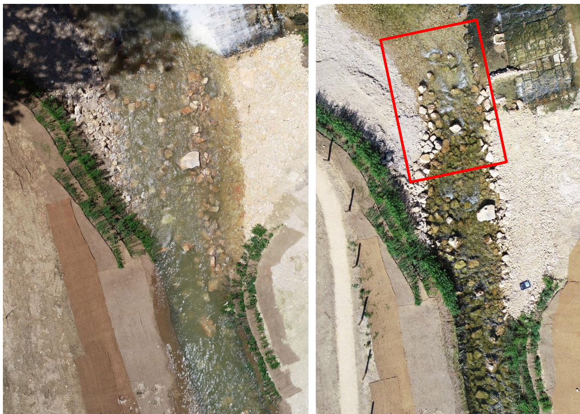
Figure 8 Vue par drone de la zone de confluence. A gauche le 18.06.2019 avec un débit du Doubs de 28 m 3 /s et à droite le 05.07.2019 avec un débit de 8 m 3 /s. La zone sensible où l'on observe des dépôts de graviers est marquée en rouge sur la photo de droite. Source : Aquarius, 2019.
