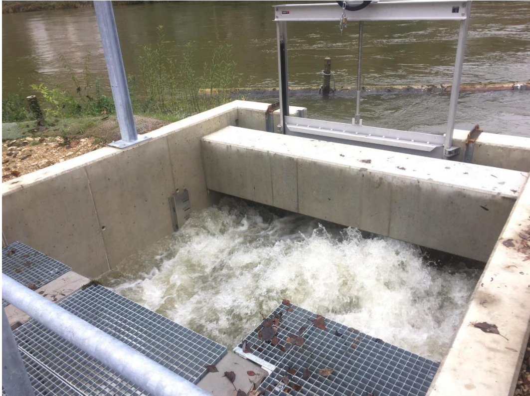
Figure 14 Prise d'eau du dispositif de montaison le 25.10.2019 avec un débit du Doubs de 63 \text{ m}^3/\text{s} . Source : Valentin Iseli, 2019.
