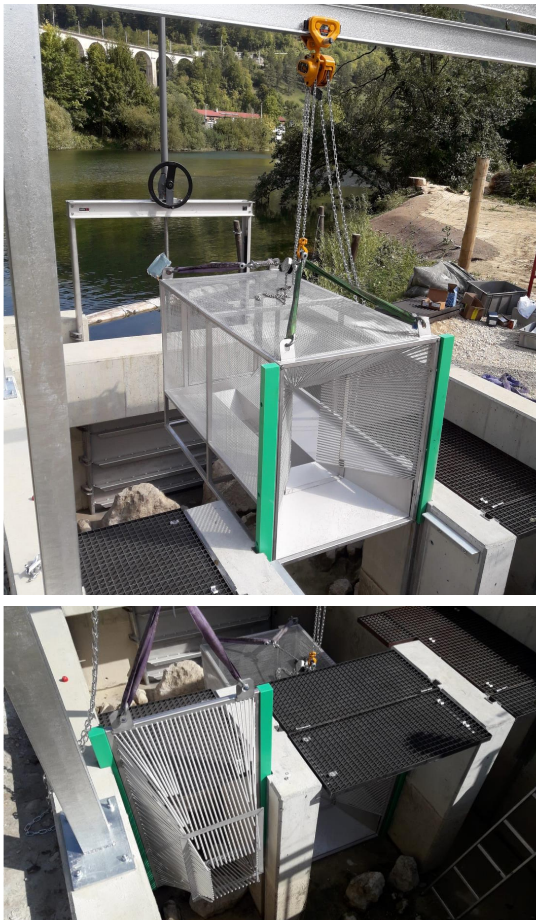
Figure 20 Nasse avec goléron en haut et goléron latéral en bas.
