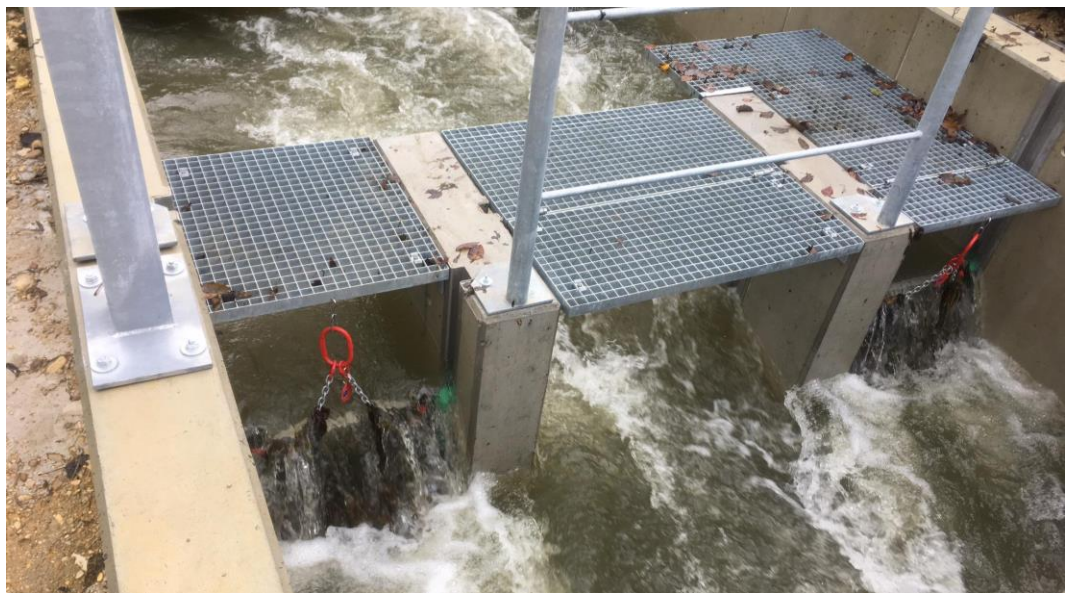
Figure 21 Dispositif de piégeage avec un débit élevé dans le Doubs : Source : V. Iseli, 2019.
