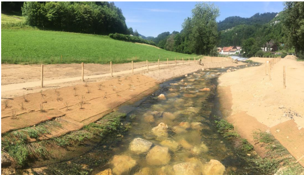
Figure 11 Rivière de contournement lors de sa mise en eau en juin 2019 avec un débit du Doubs aux alentours de 14 \text{ m}^3/\text{s} . La macrorugosité est bien visible. Source : Biotec, 2019.
