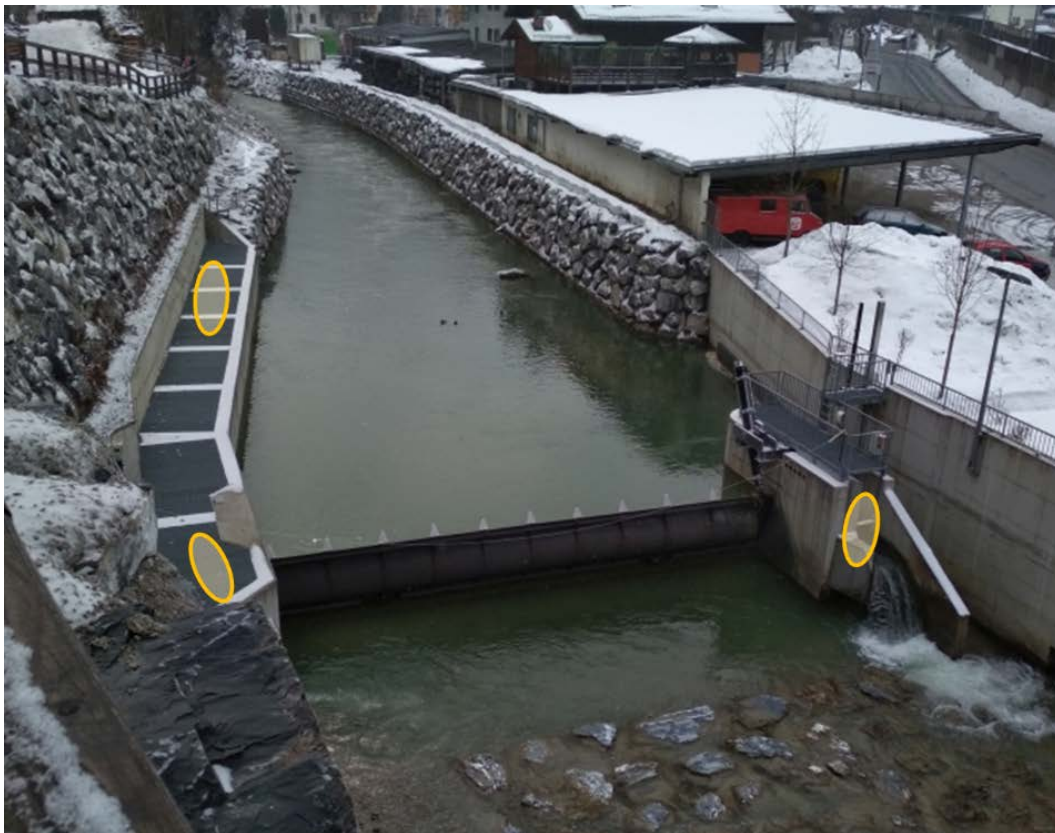
Abbildung 19: Schematische Lage der Antennen an der Wasserfassung des KW Fritzbach.
