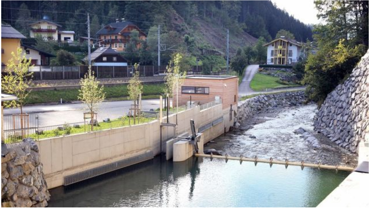
Abbildung 1: Wasserfassung des KW Fritzbach in Hütttau. Bildquelle: Salzburg AG
