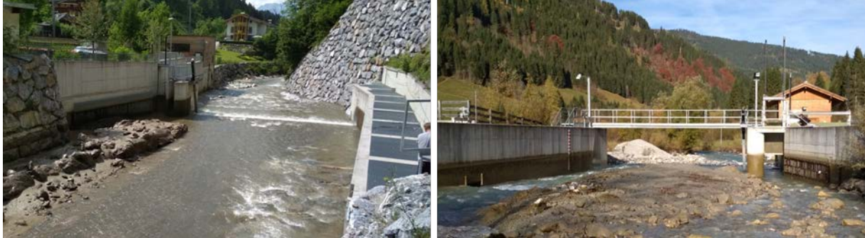
Abbildung 53: Situation bei abgesenktem Wehr an Fritzbach (rechts) und Kleinarler Ache (links).
