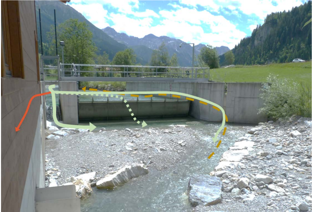
Abbildung 9: Wanderkorridore an der Wehranlage des Kraftwerks Kleinarl. Grün: Abstiegskorridor permanent verfügbar. Strichliert: Abstiegskorridor manchmal verfügbar. Rot: Abstiegskorridor permanent verfügbar, hohes Schädigungspotenzial. Gelb: Aufstiegskorridor.
