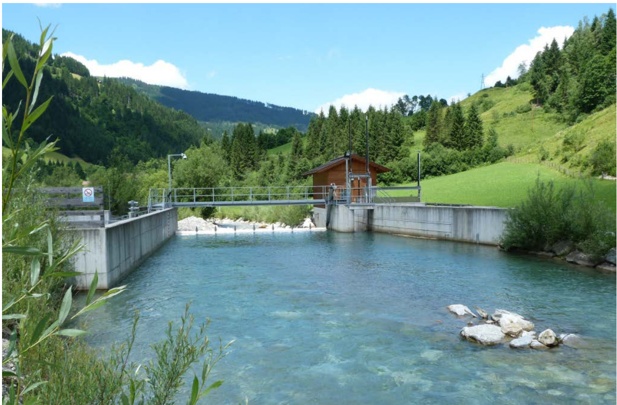
Abbildung 7: Wehranlage des KW Kleinarl. Am linken Ufer ist in die Betonwand der Einstieg in die FAH eingebaut, am rechten Gewässerrand ist die Wasserfassung mit anschließender Abstiegs/Restwasserklappe situiert.
