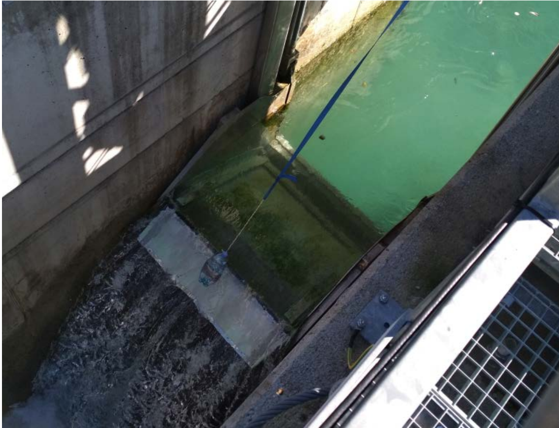
Abbildung 22: An der Abstiegsklappe der Wasserfassung Hüttau angebrachte PIT Antenne.
