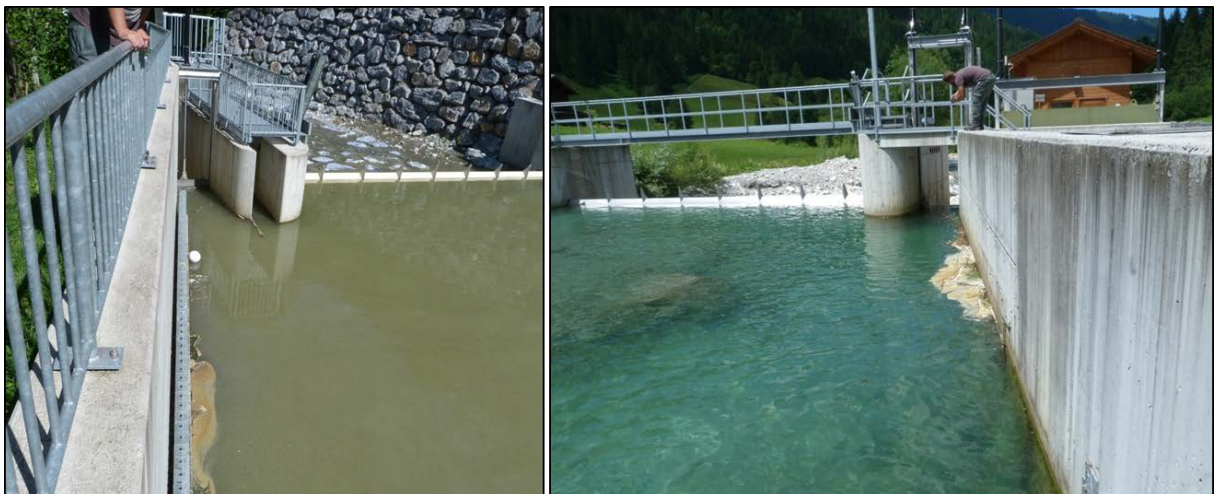
Abbildung 54: Positionierung der Abstiegsklappen am Fritzbach (links) und Kleinarler Ache (rechts).
