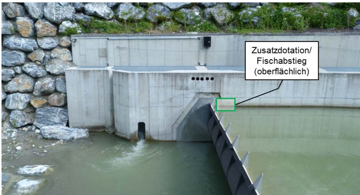
Abbildung 57 Variante zur Dotation der FAH mittels Abstiegsklappe bei gleichzeitiger Reduktion der Dotationsmenge beim ursprünglichen Einstieg.
