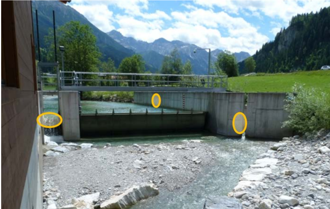
Abbildung 21: Schematische Lage der Antennen an der Wasserfassung des KW Kleinarl.
