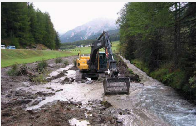
Fig. 10 Der Rombach wird von seinem engen Korsett befreit: Raumbereitstellung für die Revitalisierung im Rahmen der GM Münstertal GR
