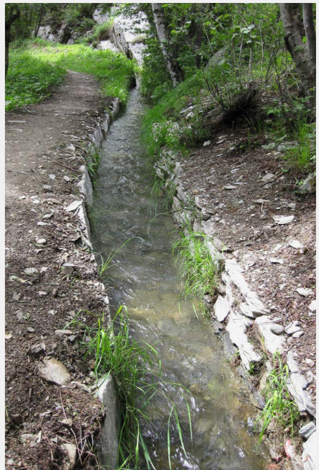
Fig. 5 Erhaltung von Suonen, den ältesten kulturtechnischen Werken, die seit Jahrhunderten das kostbare Wasser aus vergletscherten Seitentälern entlang von steilen Felswänden und Wäldern ins Bewässerungsgebiet führen
