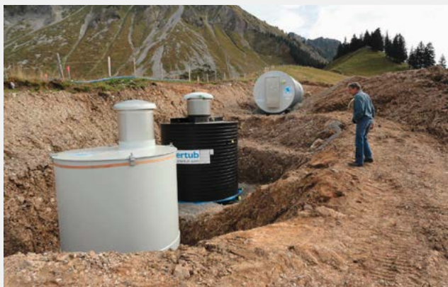
Fig. 7 Mit eingeflogenen vorfabrizierten Schächten wird auch auf Alpen eine qualitativ einwandfreie Wasserversorgung zur Lebensmittelproduktion gewährleistet Grâce à des galeries préfabriquées transportées par hélicoptère, l'approvisionnement en eau irréprochable pour la fabrication de denrées alimentaires sur l'alpage est assuré
