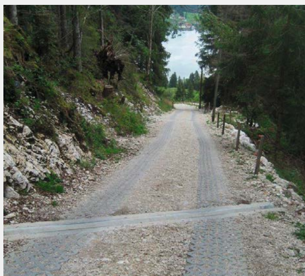
Fig. 9 Erosionssicherung und fachgerechte Wasserableitung an geeigneten Stellen sind vor allem in steilen Lagen massgebend zur Verhinderung von Schäden Les mesures de protection contre l'érosion et l'évacuation des eaux selon les règles de l'art aux endroits propices sont déterminantes, surtout dans les endroits escarpés, afin de prévenir les dommages
