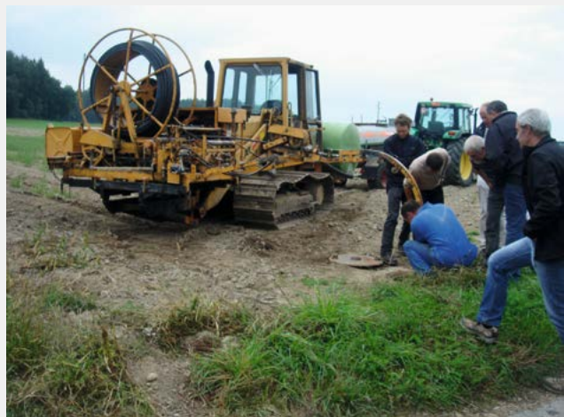
Fig. 2 Eine der effizientesten und kostengünstigsten Erhaltungsmassnahmen ist die Spülung bestehender Drainagenetze im Rahmen der PWI...
