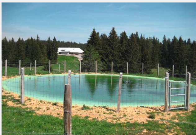
Fig. 8 Abgezäuntes Wasserbecken zum Sammeln von Schmelz- und Regenwasser für die Speisung dezentraler Tränkebrunnen auf wasserarmen Juraweiden Réservoirs d'eau entourés d'une clôture pour collecter l'eau de la fonte des neiges et l'eau de pluie pour l'alimentation des abreuvoirs dans les pâturages jurassiens pauvres en eau
