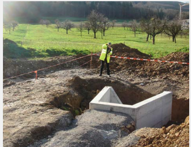
Fig. 11 In der leicht vertieften, als Vernetzungselement extensiv bewirtschafteten Abflussmulde wird der Oberflächenabfluss aus Wald und Flur abgeleitet und gebremst, bevor er in den im Bau befindlichen Sammler der Siedlungsentwässerung eingeleitet wird, GM Hofstetten-Flüh SO
