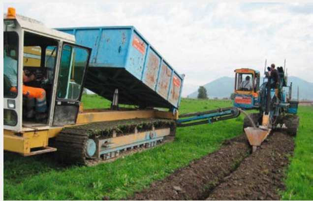
Fig. 1 Erneuerung von Drainagenetzen mit bodenschonenden Bauverfahren (reduzierte Bodenbelastung, minimaler Bodeneingriff, ein einziger Arbeitsgang)
