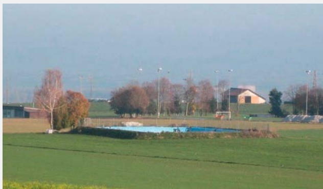
Fig. 6 Gemeinschaftliches offenes Bewässerungsreservoir als Zwischenspeicher zur Optimierung der privat organisierten Wasserverteilung auf die einzelnen Parzellen Réservoir à ciel ouvert d'eau d'irrigation géré en commun, en tant que réservoir intermédiaire en vue de l'optimisation de la répartition de l'eau sur les différentes parcelles, organisé par des particuliers
