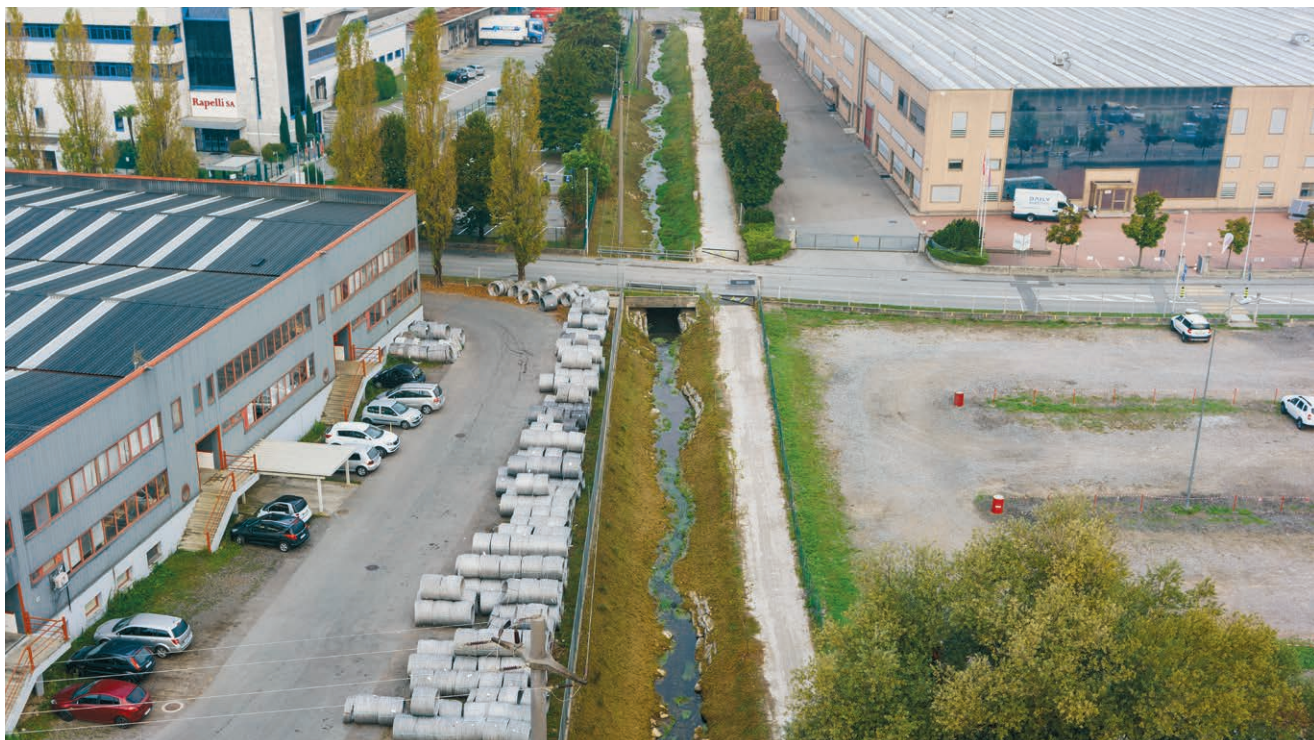
Vom Problembach zum Schulbeispiel: der Gurungun in Stabio/TI.
