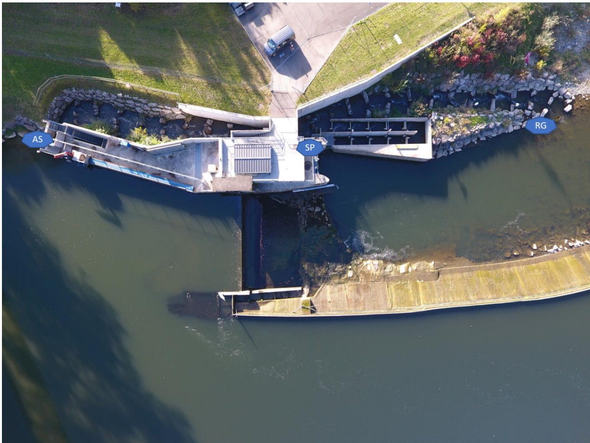
Abbildung 2: Das Dotierkraftwerk Schiffmühle aus der Luft. Die Fließrichtung der Limmat ist von links nach rechts. Zu erkennen sind die beiden Einstiegsarme der FAH, das Raugerinne (RG) und der Schlitzpass (SP), sowie der Ausstieg aus der FAH ins Oberwasser (AS). Unten im Bild ist der Ausleitungskanal in Richtung Hauptkraftwerk.
