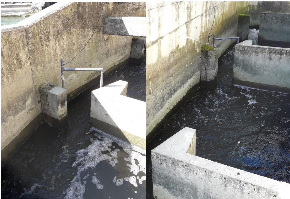
Abbildung 1: Antennen im Schlitzpass des KW Aue. Links: Unterste Antenne am Einstieg. Rechts: Obere Antenne am Einstieg.
