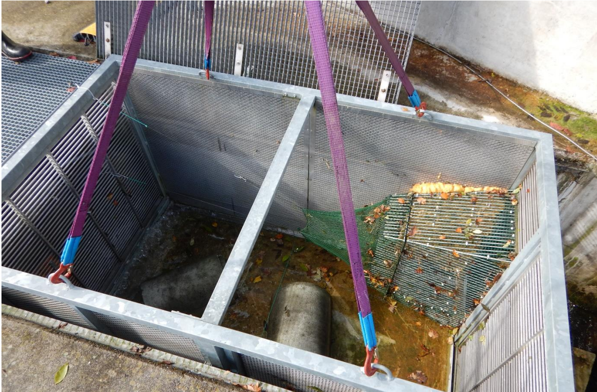
Abbildung 12: Heben der Reuse am KW Aue.
