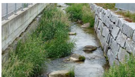
Bild 13: Entwicklung eines Niederwassergerinnes mit Instream-Massnahmen. (Fotos: Kt. LU, vif, Abt. Naturgefahren).
