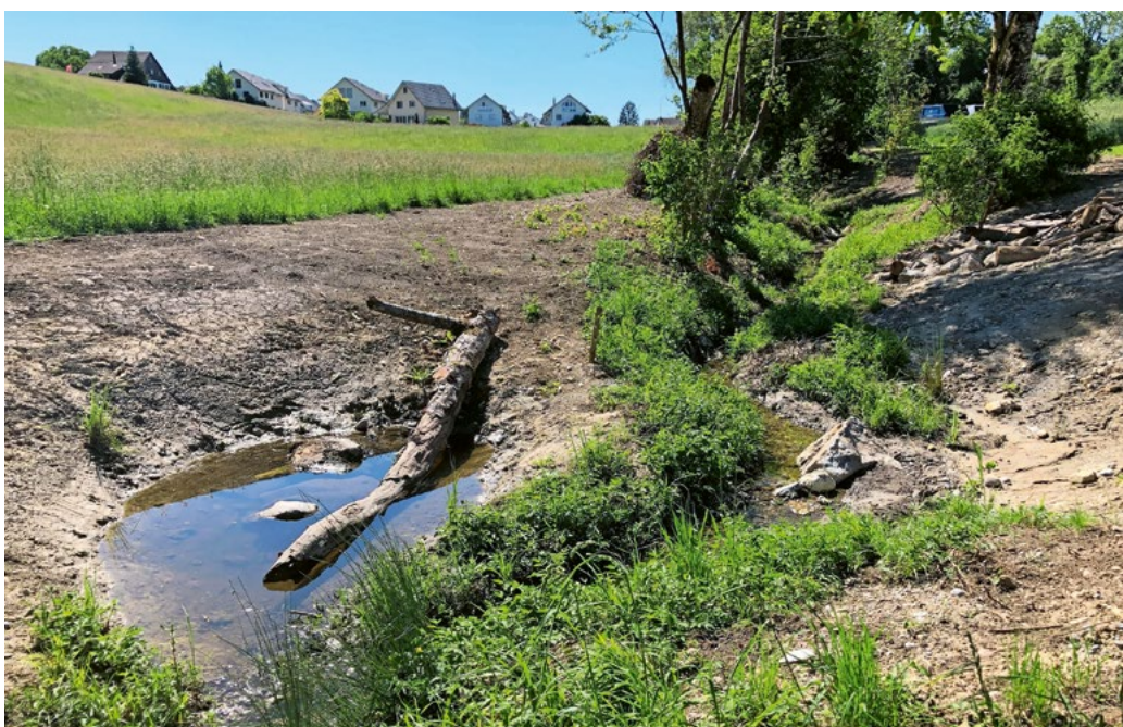
Auf den nährstoffarmen Abtragsflächen haben sich nach und nach im trockenen und wechselfeuchten Bereich artenreiche Wiesen- und Krautsaumgesellschaften gebildet. Letzteres schattiert das Gerinne fast vollständig. Das Bild entstand kurz nach Bauvollendung. (© S. Winiger)
