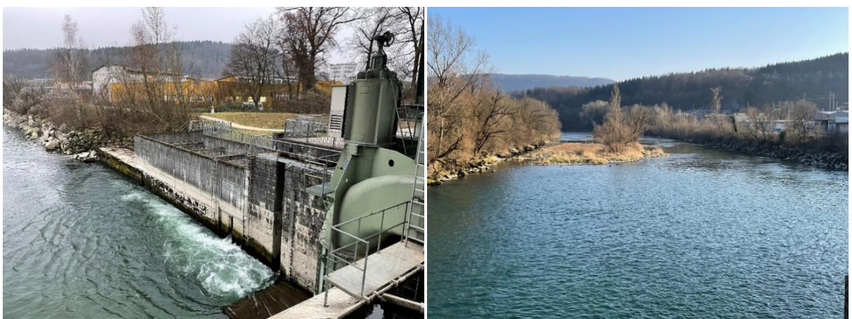
Abbildung 2 Links: Einstieg in das Umgehungsgerinne am Wehr Winznau in der Aare. Rechts: Aare mit Restwasserstrecke nach der Ausleitung am Wehr Winznau. Das Flussbett ist hier zirka 70 m breit. Daher soll die oberste Strecke für die Bestandserhebung zur Erfassung des Migrationspotentials am Wehr Winznau mindestens 700 m (10-fache Flussbreite) unterhalb der Fische aufstiegshilfe liegen. Die Restwasserstrecke ist 8.4 km lang. In dieser Strecke sind zwei Bestandserhebungen durchzuführen. Eine dritte Befischungsstrecke ist in die 8.4 km entfernte Vollwasserstrecke zu legen. Somit wird in der Aare das Aufstiegspotential auf einer Fließstrecke von zirka 10 km unterhalb der FAH berücksichtigt. Bei der grossen Breite der Restwasserstrecke wird die Methode der Streifenbefischung eingesetzt.
