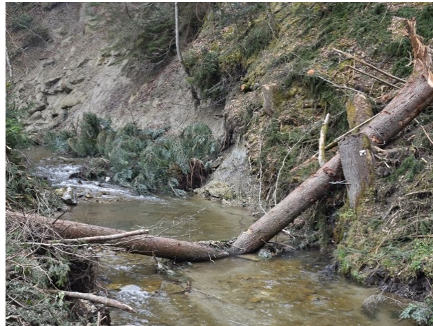
Direkt nach Bauabschluss, 2016
