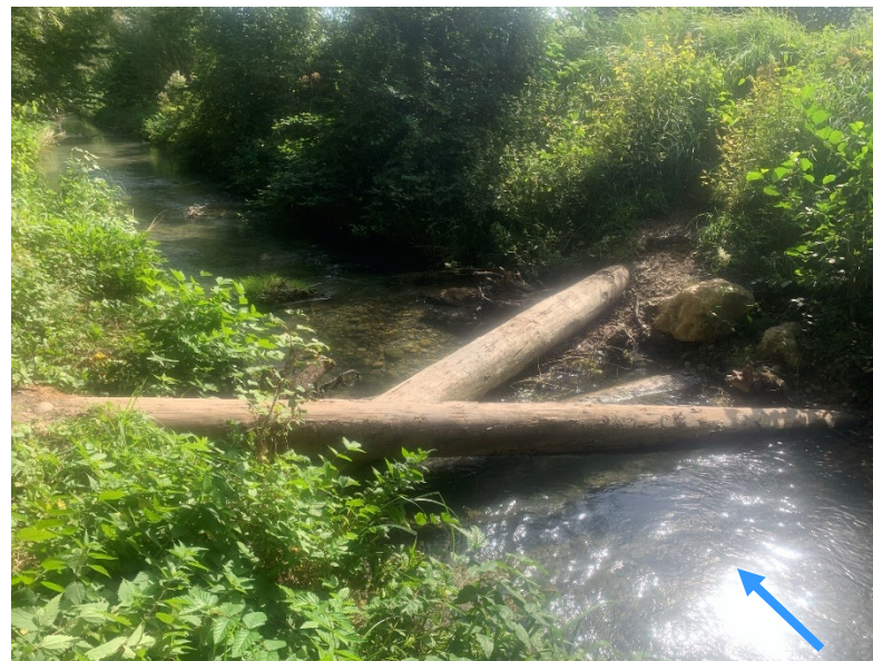
Stammhölzer rund 1 Jahr später - Hält einem rund HQ 80 stand - Kolkbildung von rund 90 cm
