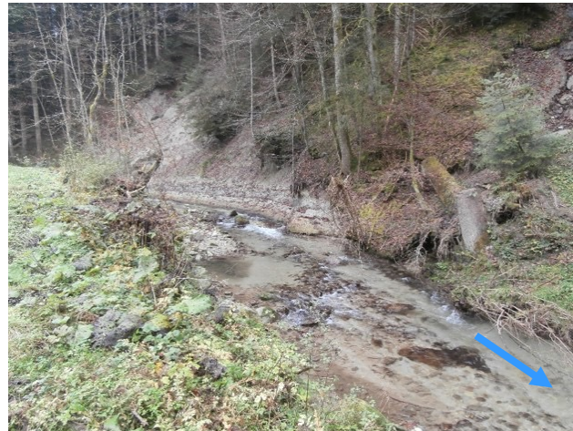
Vor dem Einbau
