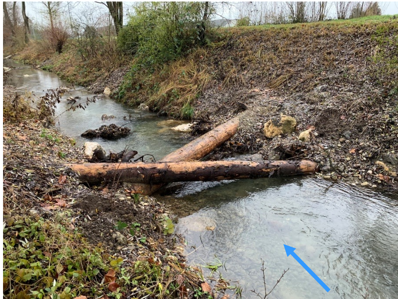
Stammhölzer kurz nach dem Einbau
