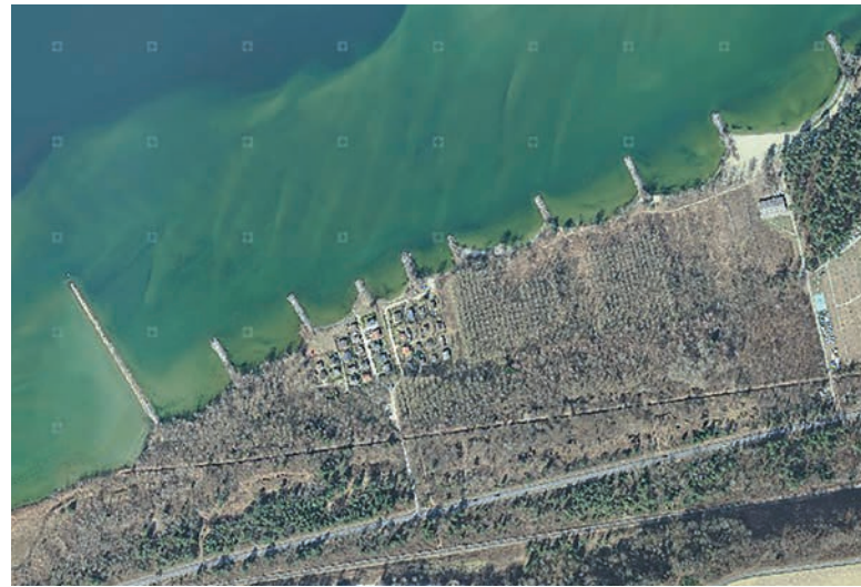
Abb. 11: Molen am Neuenburgersee zur Verminderung der Wellenerosion. Deutlich ist die Haldenkante zwischen dem hellen Flachwasser und dem dunklen Tiefwasser erkennbar (map.geo.admin.ch) | Fig. 11: Des jetées sur le lac de Neuchâtel pour réduire l'érosion par les vagues. Le mont est clairement visible entre les eaux claires peu profondes et les eaux sombres profondes (map.geo.admin.ch)
