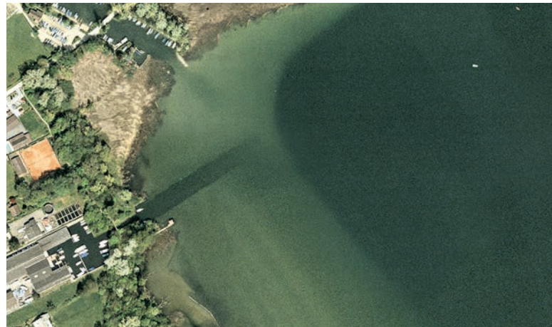
Abb. 5: Die für die Zufahrt zur Bootswerft in der Flachwasserzone ausgebaggerte Schifffahrtsrinne wirkt als Sedimentfalle und unterbricht den uferparallelen Sedimenttransport. Damit entsteht ein Feststoffdefizit in den angrenzenden Uferbereichen und die Erosion wird gefördert. Gleichzeitig füllt sich die Rinne mit Sedimenten auf. [Erlach, Bielersee] | Fig. 5: Le canal de navigation dragué dans la beine lacustre pour l'accès au chantier naval agit comme un piège à sédiments et interrompt le transport de sédiments parallèle à la rive. Cela crée un déficit de matières solides dans les zones riveraines adjacentes et favorise l'érosion. En même temps, le canal se remplit de sédiments [Erlach, lac de Bienne]
