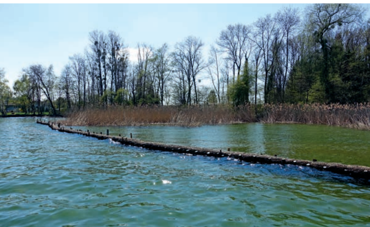
Abb. 25: Lahnungen dämpfen die Wellen und wirken bei starkem Wellengang als Sedimentfallen [Erlach, Bielersee] | Fig. 25: Les barrages à claire-voie amortissent les vagues et agissent comme des pièges à sédiments en cas de forte houle [Erlach, lac de Biemme]
