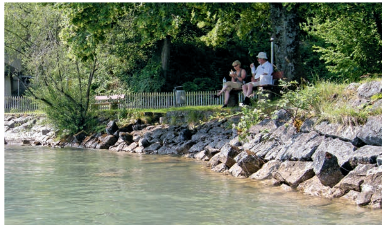
Abb. 6: Die natürliche Übergangszone Wasser–Land wird durch einen Blocksatz weitgehend zerstört. Ausserdem beeinträchtigt er die Zugänglichkeit zum Wasser | Fig. 6: La zone de transition naturelle eau – terre est en grande partie endommagée par un ensemble de blocs, qui entrave également l'accès à l'eau
