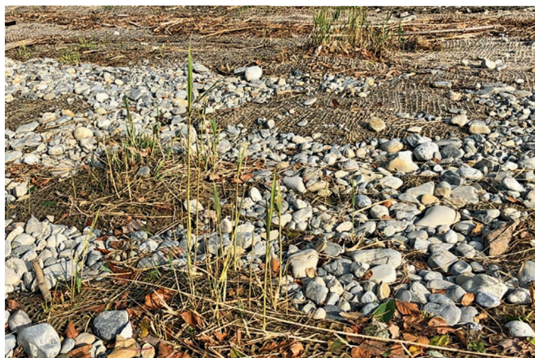
Abb. 32: Die in die Kiesschüttung oberhalb der Mittelwasserlinie eingegrabenen und mit einem Jutenetz gesicherten Schilfsoden treiben auch ohne stehende Althalme aus [Brunnen, Vierwaldstättersee] | Fig. 32: Les mottes de roseaux, enfouies dans le gravier au-dessus de la ligne des eaux moyennes et protégées avec un filet de jute, poussent même sans vieilles tiges sur pied [Brunnen, lac des Quatre-Cantons]
