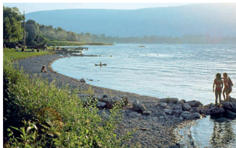
Abb. 13: Nach dem Rückbau des Blockwurfes beim Strandbad Erlach (Bielersee) wurde das Ufer abgeflacht und mit einer Kiesschüttung gesichert. Mehrere Buhnen sorgen dafür, dass der Kies nicht seitlich verlagert wird | Fig. 13: Après le démantèlement de l'enrochement à la plage de Cerlier (lac de Bièvre), la rive a été aplanie et consolidée par un remblai de graviers. Plusieurs épis veillent à ce que le gravier ne soit pas déplacé latéralement
