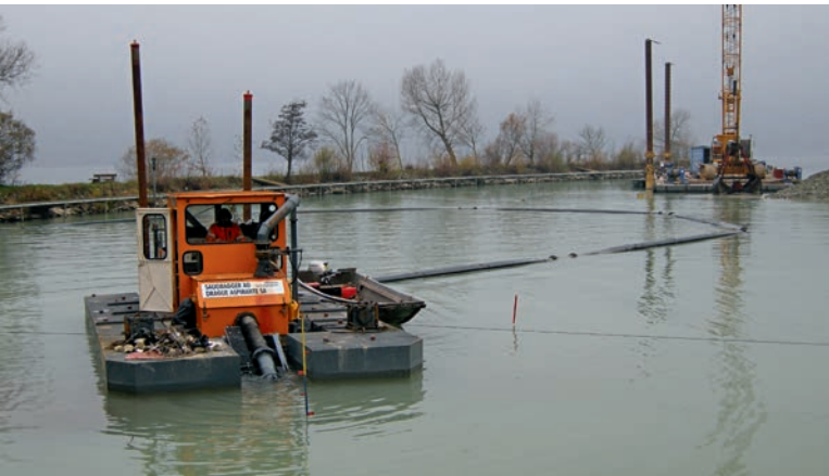
Abb. 27: Saugbagger bei der Ausbaggerung des Hafens Mörigen [Bielersee] | Fig. 27: Dragage aspiratrice lors du dragage du port de Mörigen [lac de Bièvre]
