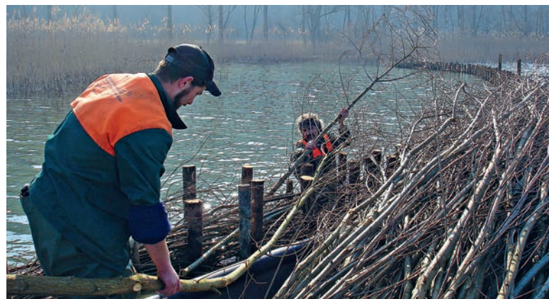
Abb. 24: Der Bau von Lahnungen erfolgt vorwiegend in Handarbeit [Lüscherz, Bielersee] | Fig. 24: La construction des barrages à claire-voie se fait principalement à la main [Lüscherz, Lac de Bienne]
