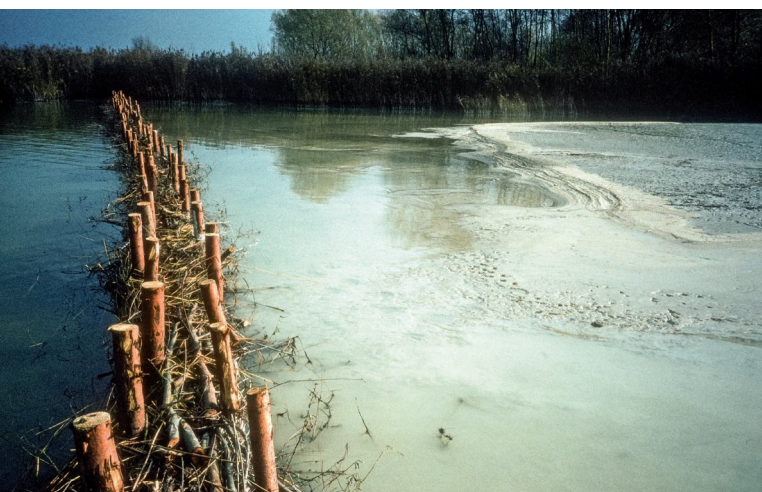
Abb. 6: Bei der ersten Sandspülung am Bielersee (1991) wurden in Erlach rund 1'800 m 3 Sediment hinter eine temporäre Lahnung gespült. | Fig. 6 : Lors du premier sable de reconstitution au lac de Biemme (1991), environ 1'800 m 3 de sédiments ont été remblayés derrière une palissade provisoire à Erlach.
