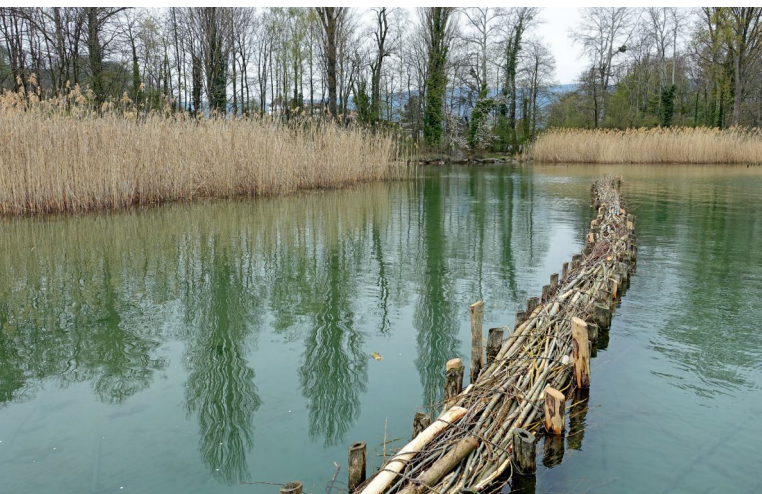
Abb. 3: Frisch aufgefüllte Lahnung in Erlach (Element E5). Aufnahme 16.04.2019, Wasserstand 429,38 m ü.M. | Fig. 3 : Barrage à claire-voie à Erlach, fraîchement remplie (élément E5). Photo du 16.04.2019, niveau de l'eau à 429,38 m.s.m.
