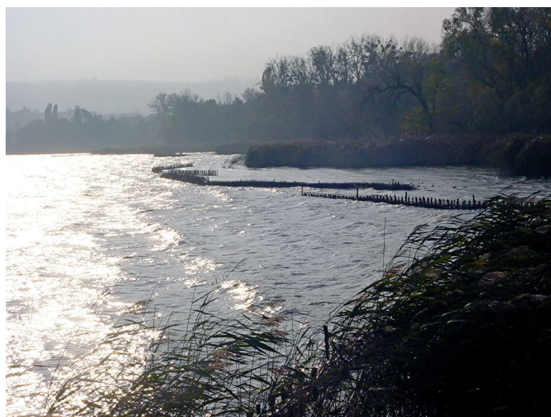
Abb. 4: Lahnungen in Erlach wirken als Wellenbrecher und als Sedimentfallen. | Fig. 4 : Les barrages à claire-voie à Erlach agissent comme des brise-lames et des pièges à sédiments.
