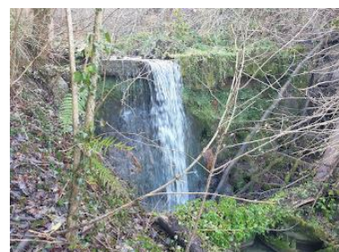
Abbildung 17: Stauwehr KW Schneggentöbeli, Lutzenberg / Rheineck (AFU, AR)
