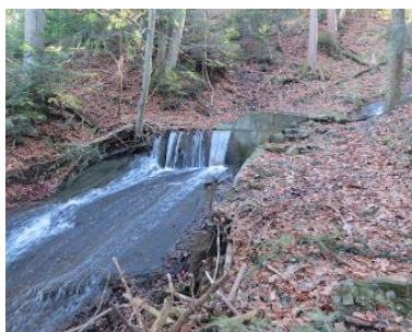
Abbildung 18: Fassung ehemaliges KW Lebau, Walzenhausen
