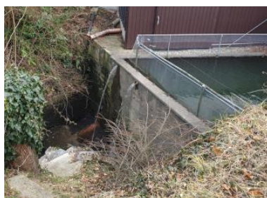
Abbildung 16: Stauweiher KW Gaismoos, Walzenhausen (AFU, AR)
