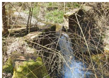
Abbildung 5: Stauwehr Sägerei Oberwies, Lütisburg
