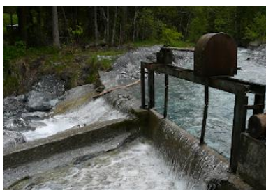
Abbildung 6: Fassung KW am Görbsbach, Pfäfers
