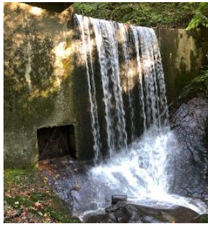
Abbildung 10: Stauwehr KW Ulisbach, Wattwil (M. Lehner)
