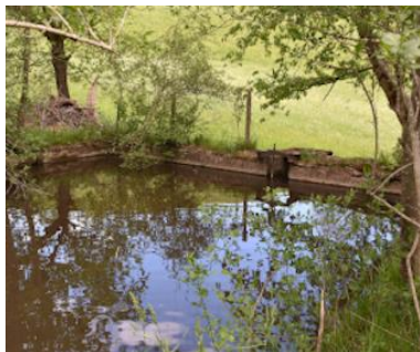
Abbildung 14: Retentionsbecken bei der Fehrbachmühle, Mels
