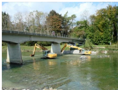
Bau der Brückensicherung
