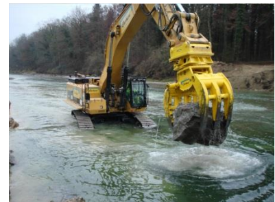
Bau der Lenkbuhnen
