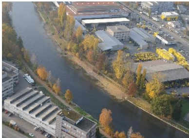
Kiesschüttungen und Ufersicherung (© AWEL Luftaufnahme)
