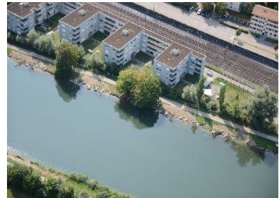
Flachufer, Buchten, Schüttungen Allmend (© AWEL Luftaufnahme)
