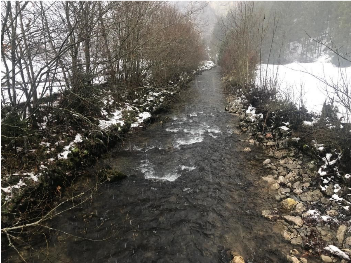
Abb. 18 Der Jaunbach auf Höhe der Brücke Pont du Roc Abschnitt T2, km 8.84, am 2.12.2021
