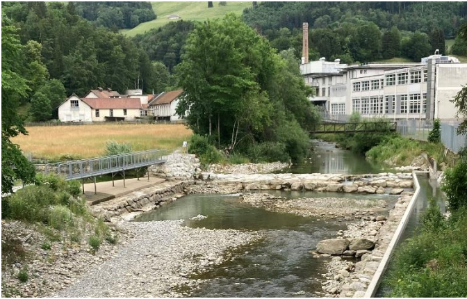
Einleitstelle des turbinierten Wassers in Broc (FR) und Entnahmestelle für das Umgebungsgewässer in die Aue. Foto: Simone Knecht.
