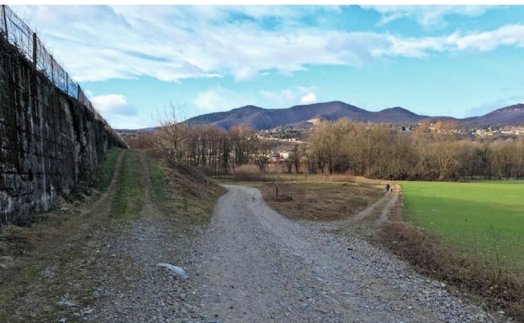
Vorher: Das Gebiet bei Genestrerio vor der Revitalisierung mit der eingedolten Strecke unter dem Rebberg am linken Bildrand. (© Comal.ch)
