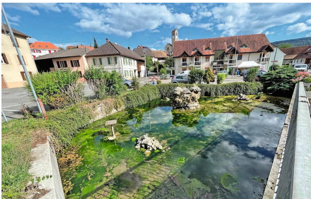
Fig. 1 Avant travaux, juillet 2022.
