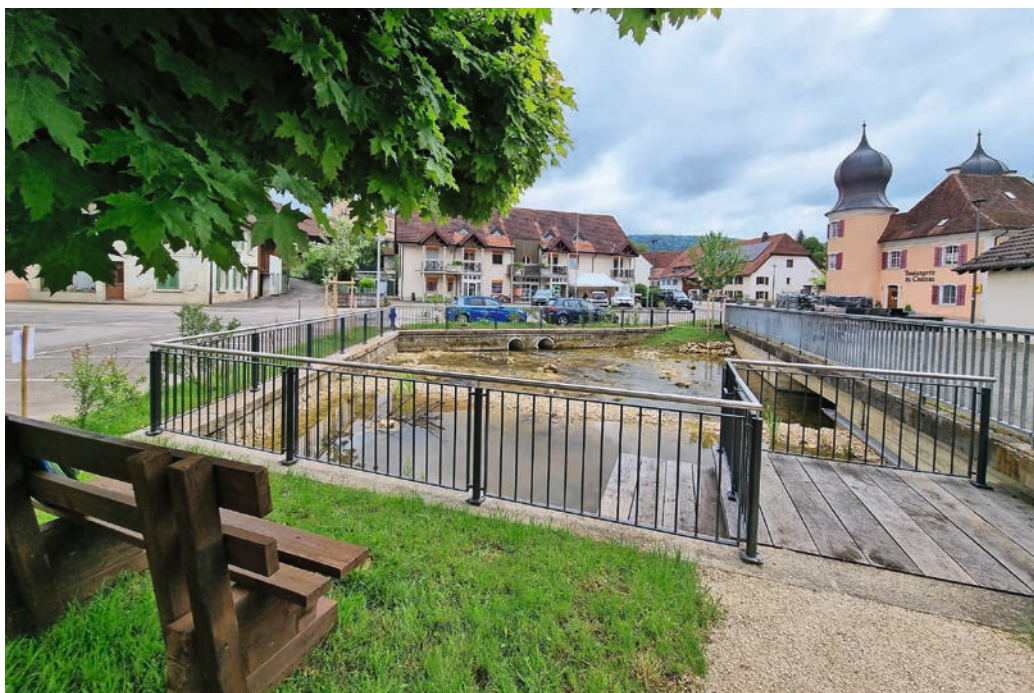
Fig. 4 Après travaux, mai 2024
