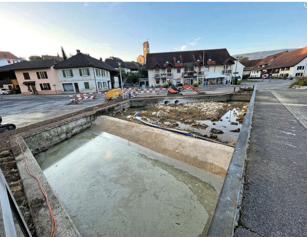
Fig. 2 Pendant les travaux, septembre 2023.
