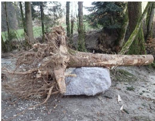
Abbildung 5: Erstellter Wurzelstein (Stammanteil ca. 2 m).
