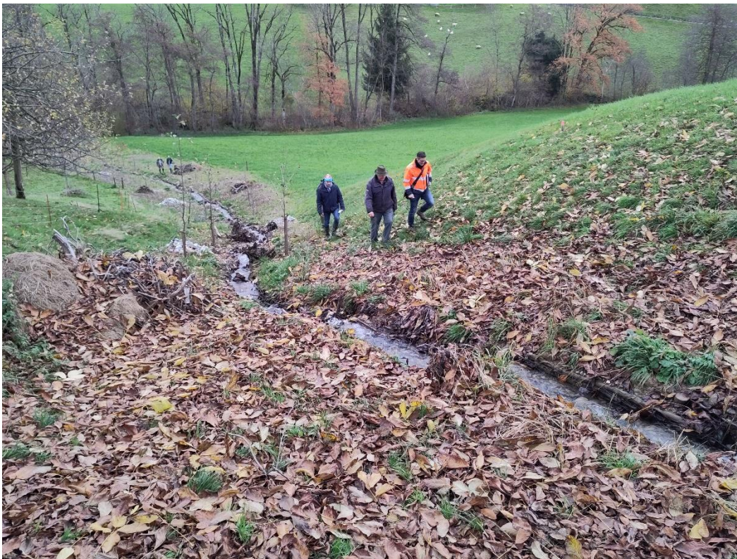
Steilstrecke mit Wurzelstock-Schwellen [Schlussabnahme November 2022]
