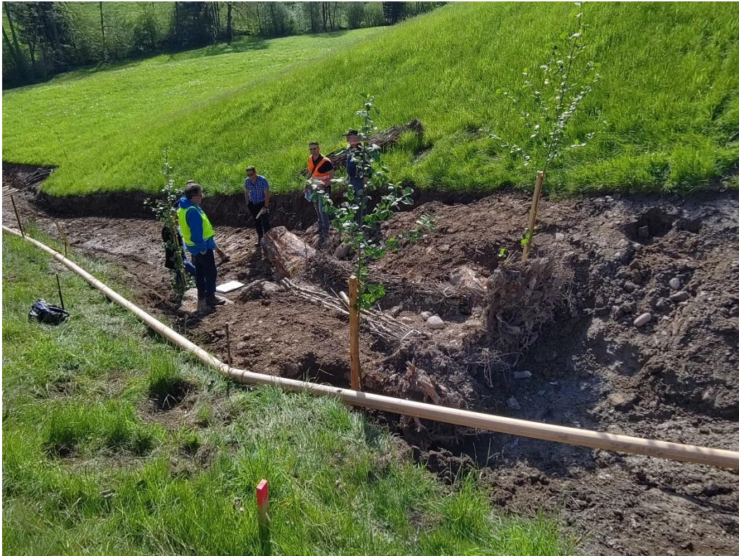
Abbildung 9: Begutachtung Musterstrecke Bachlauf mit zwei Wurzelstock-Schwellen vor Überschüttung (Mai 2022)
