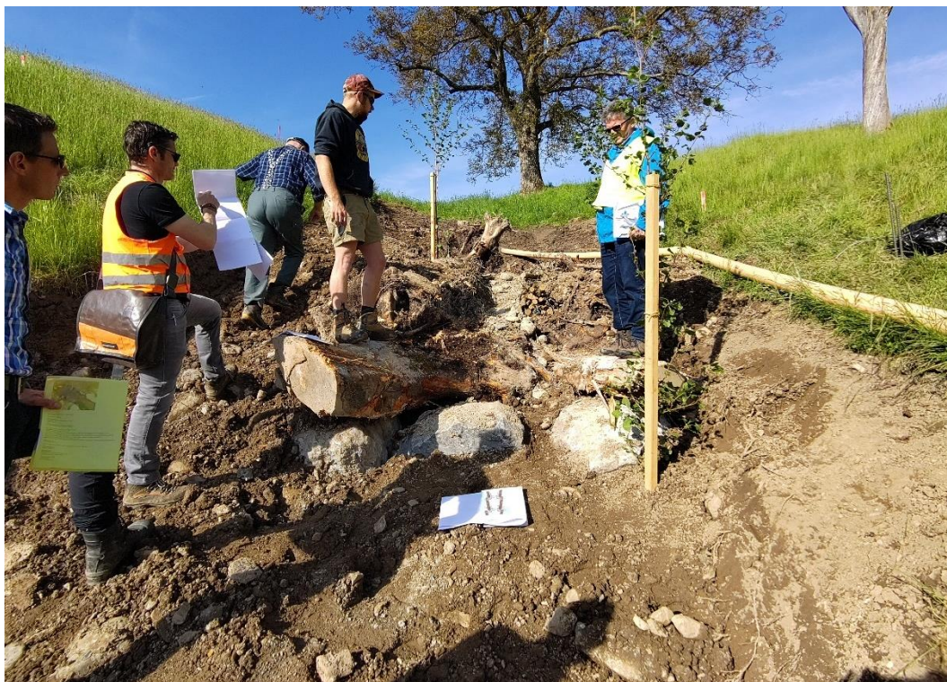
Abbildung 8: Musterstrecke Wurzelstock-Schwelle vor Überschüttung, Blick gegen Fließrichtung (Mai 2022)
