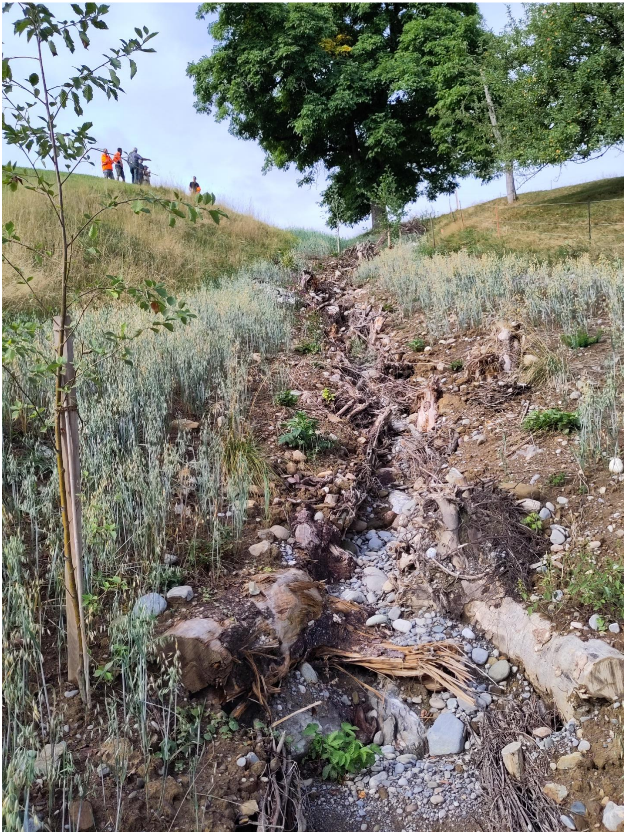
Abbildung 12: Ausschnitt Steilstrecke mit Wurzelstock-Schwellen im Rohzustand, ohne Wasserführung (August 2022)
