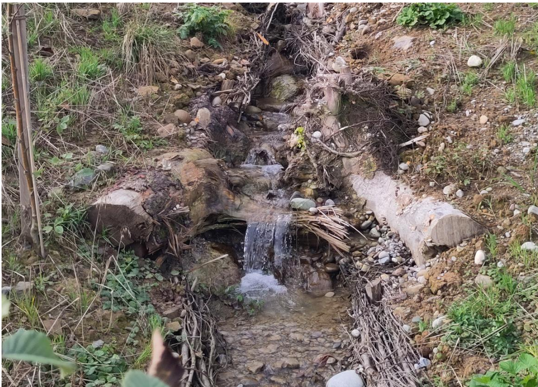
Abbildung 1: Ausschnitt aus Bachstrecke mit Wurzelstock-Schwellen, Risi-/ Chaltenbodenbach, Wädenswil
