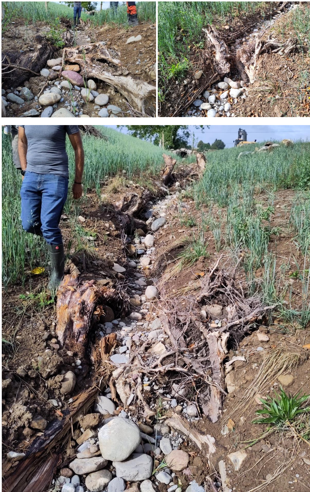
Abbildung 11: Ausschnitt Steilstrecke mit Wurzelstock-Schwellen im Rohzustand, ohne Wasserführung (August 2022)
