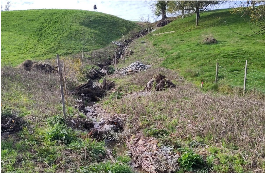
Abbildung 14: Steilstrecke mit Wurzelstock-Schwellen [Oktober 2022]
