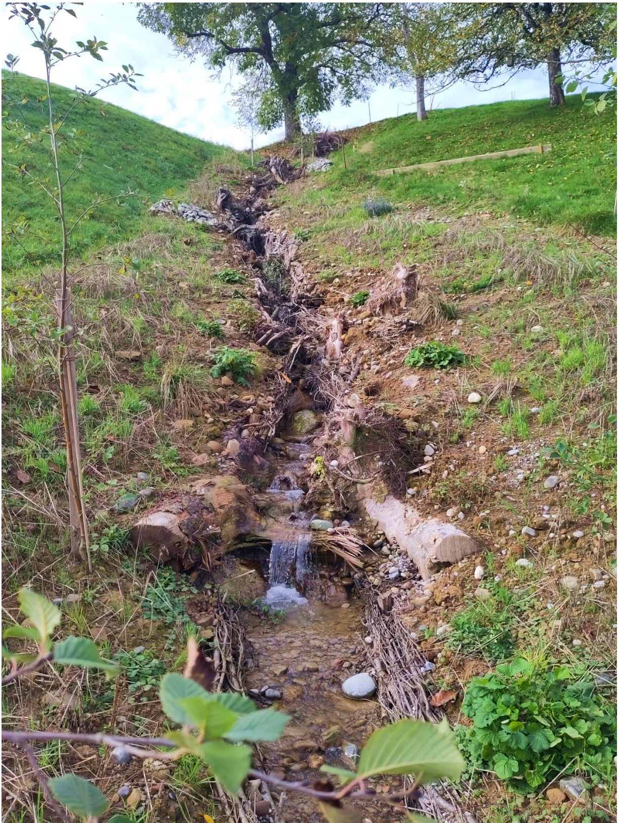
Abbildung 13: Ausschnitt fertige Steilstrecke mit Bachgerinne und Wurzelstock-Schwellen [Oktober 2022]
