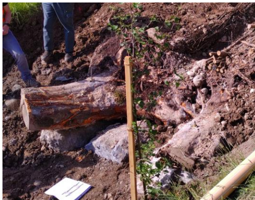
Abbildung 6: Versetzte Wurzelsteine (Stamm ca. 1.5 m) vor Überschüttung
