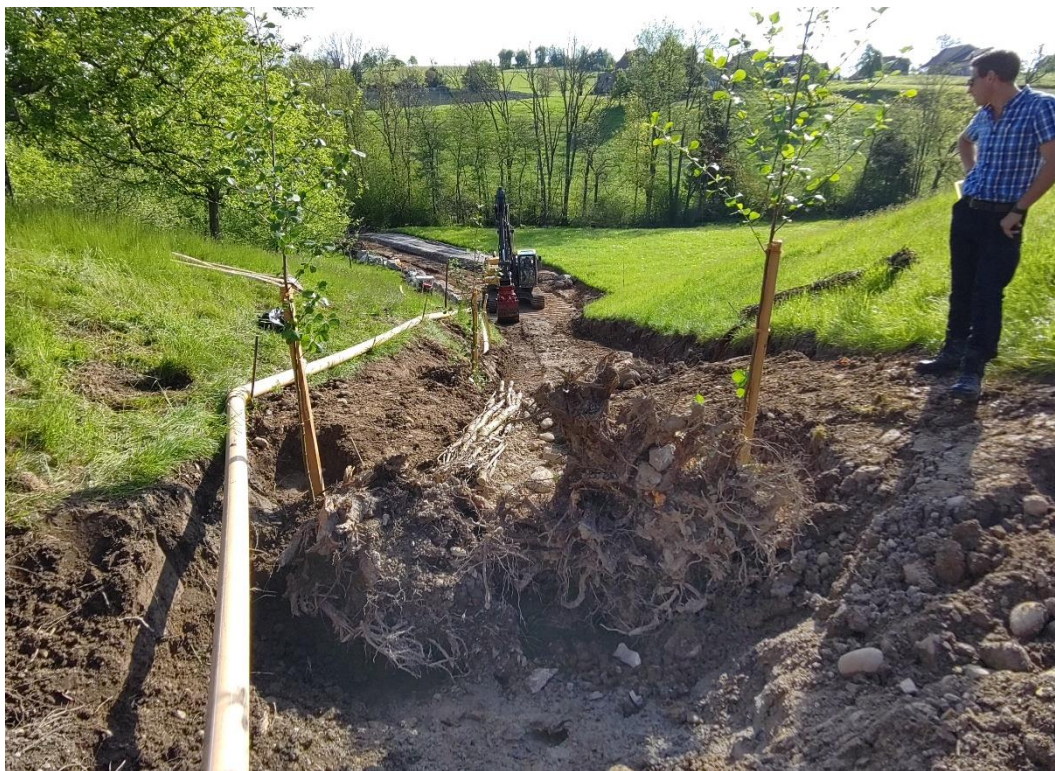
Abbildung 7: Musterstrecke Wurzelstock-Schwelle vor Überschüttung, Blick in Fließrichtung (Mai 2022)
