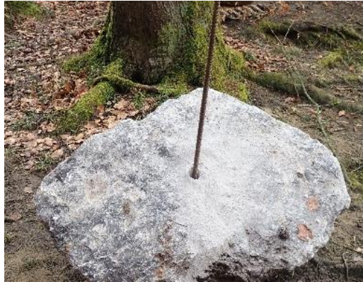
Abbildung 4: Ankerstein mit versenktem Spreizdübel und Gewindestab.
